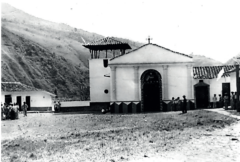
Iglesia antigua de Mucutuy, 1950. FOTOGRAFÍA: José Aquiles Sulbarán.
